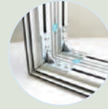
Verbindung von Eckabschnitten durch Schraubwinkel
